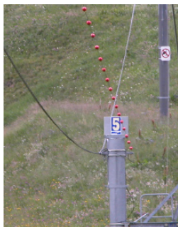
Cordelines de téléski équipées de dispositifs de visualisation
